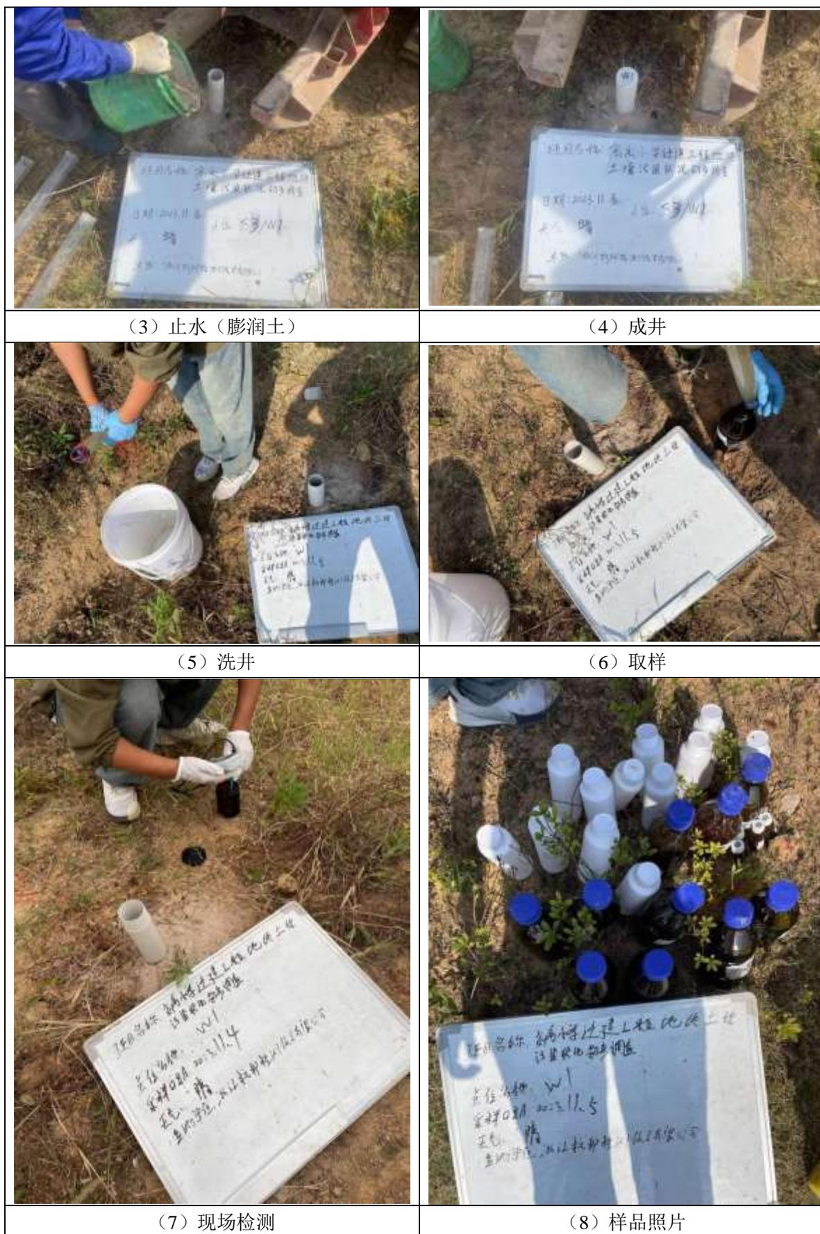
图5-9 部分地下水建井、洗井、检测照片
