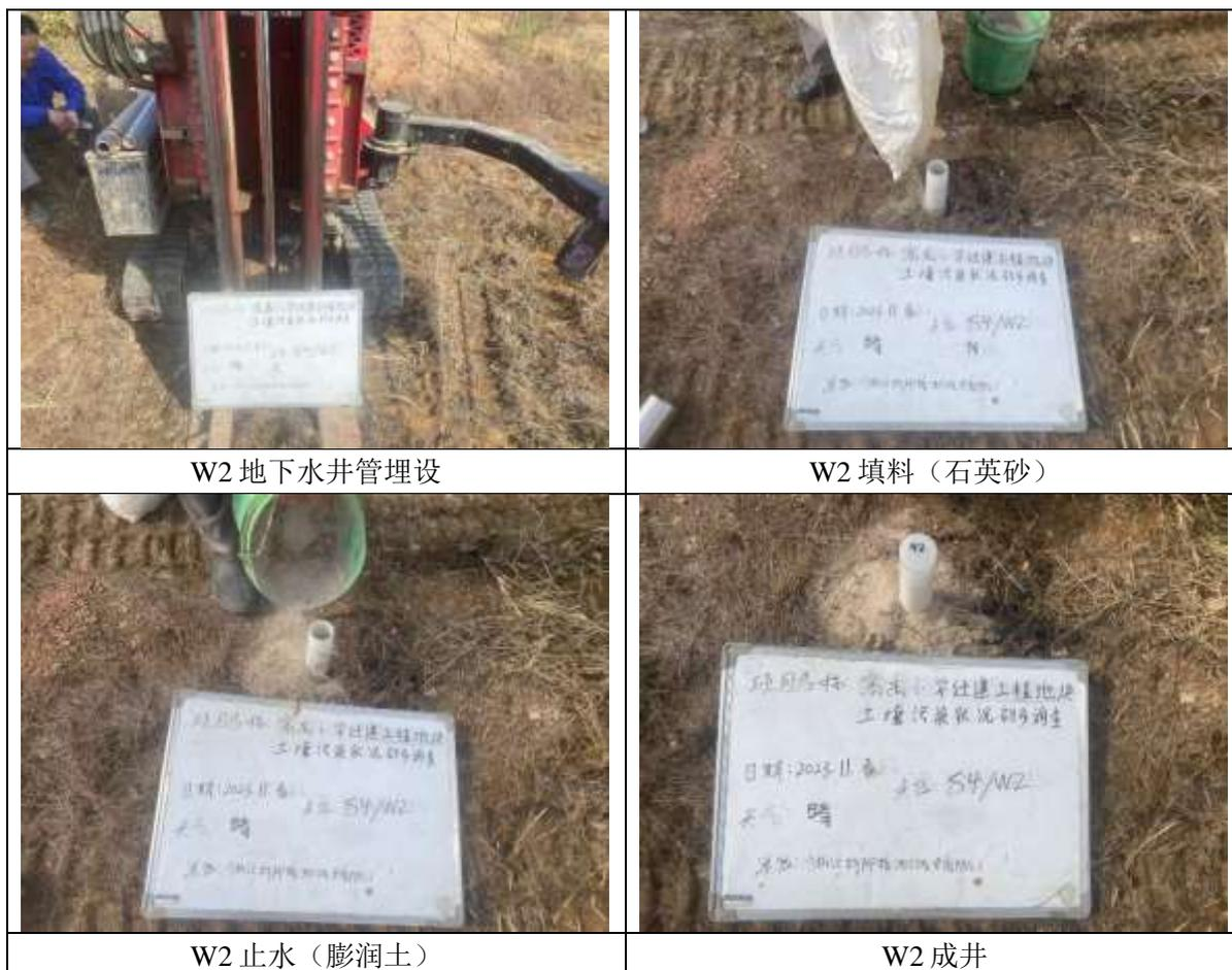
图5-4 地下水点位（W2）建井及成井洗井照片
