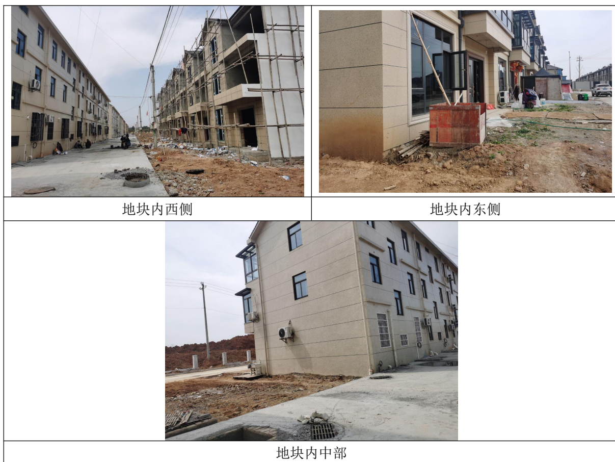
图 3-9 地块现状照片
