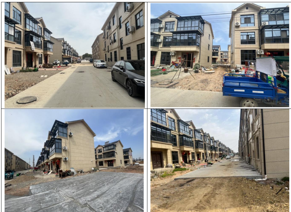
图 3-9 地块内现状照片
