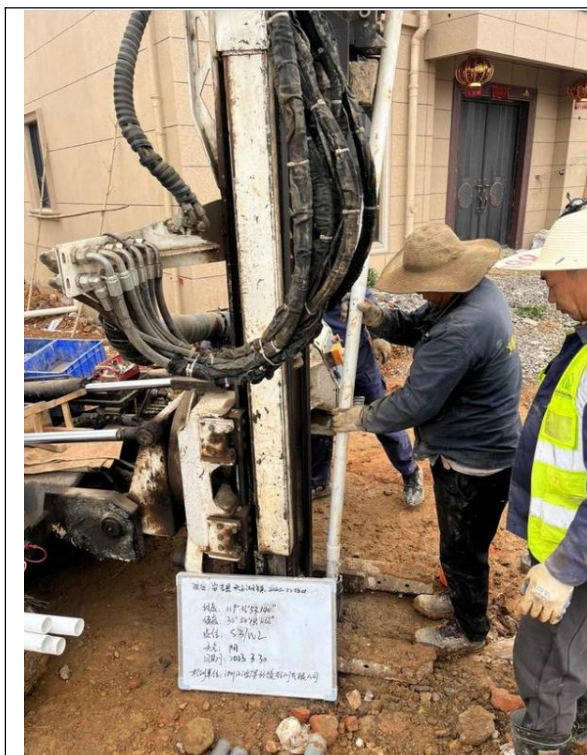
(1) 地下水井管埋设
