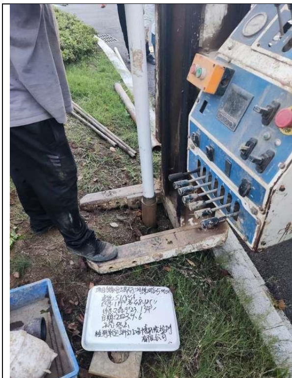
(1) 地下水井管埋设
