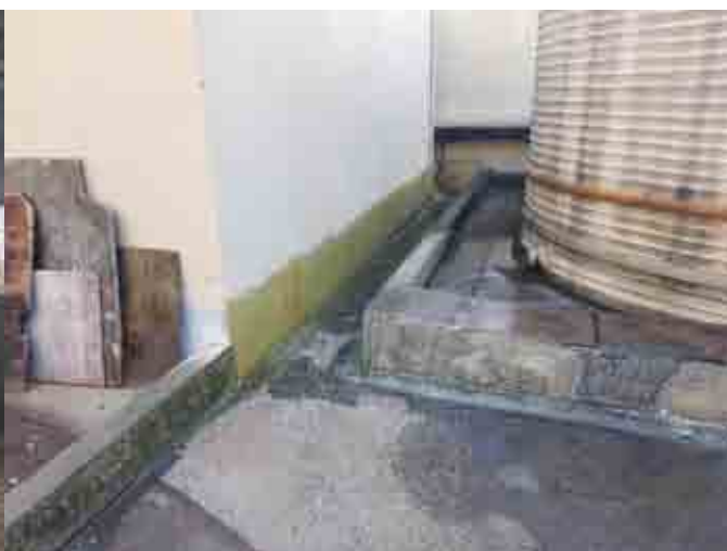
储罐区(已防腐)
