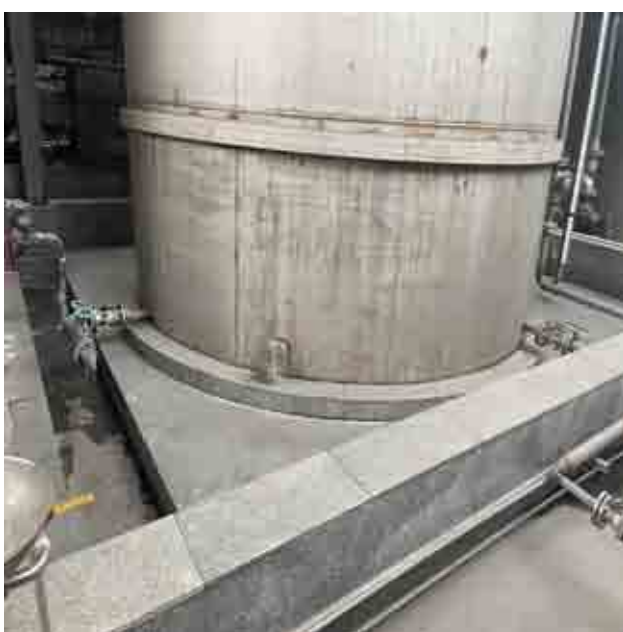
储罐区(已防腐)
